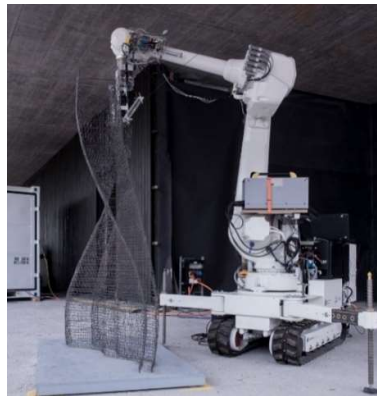
Εικόνα 2: Φορητό ρομπότ ψεκασμού κονιαμάτων - ETH Zurich
